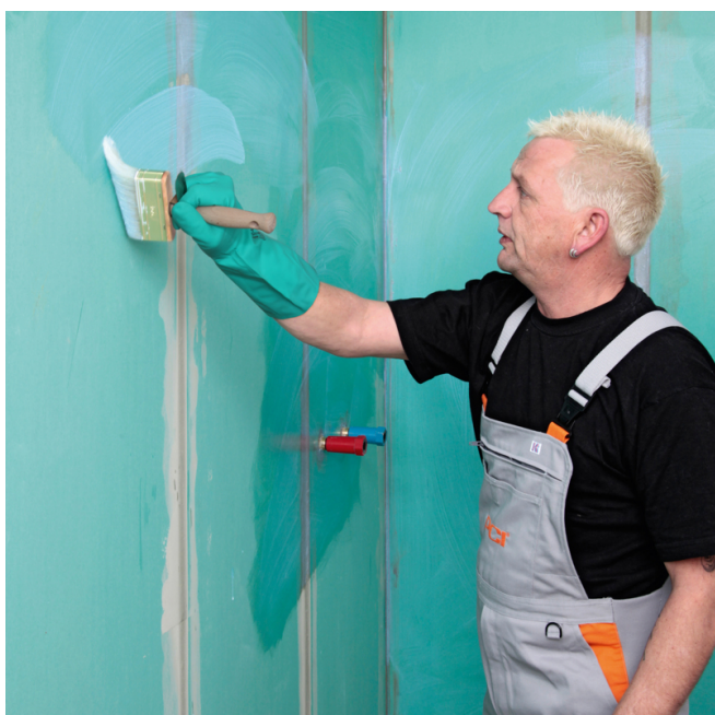
1. Penetrace: savé minerální nebo sádrové podklady a sádrokartonové desky natřít penetrací PCI Gisogrund®.
