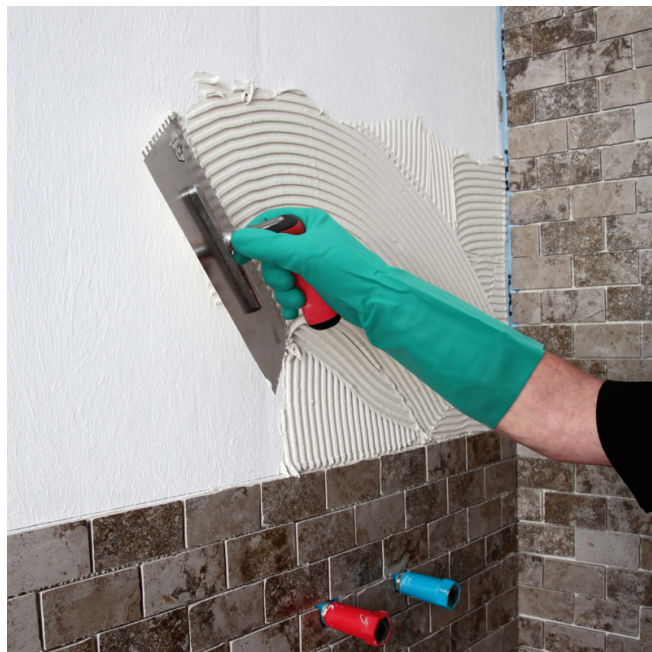
6. Po vytvrdnutí izolační vrstvy PCI Lastogum® je možné začít s montáží keramických dílců.
