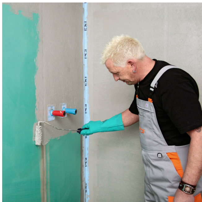
4. První vrstva neředěné izolace PCI Lastogum® (šedý) se nanese celoplošně a sytě na podklad.
