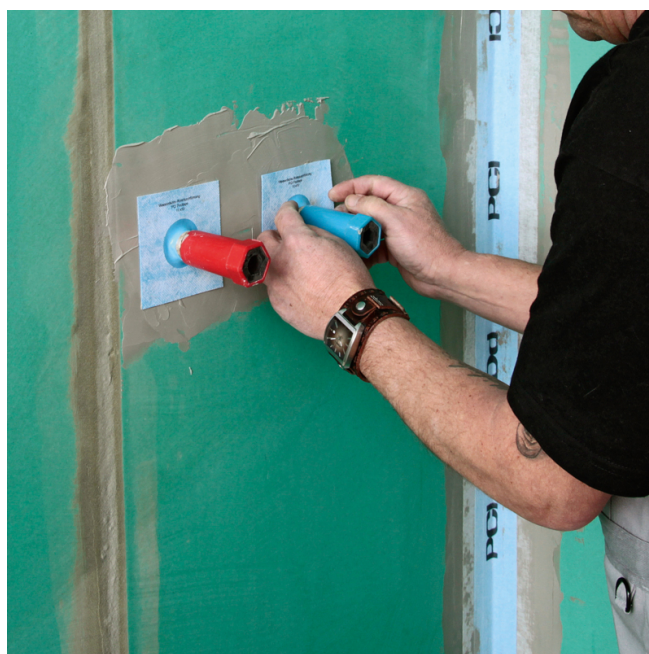
2. PCI Pecitape® 10 x 10 nasadit přes připojení potrubí vyčnívající ze zdi a zaizolovat pomocí PCI Lastogum® (šedá).
