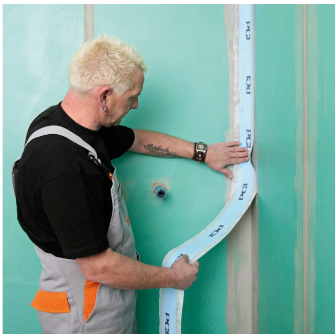
3. K utěsnění rohových spár a u spoje stěna podlaha se použije jedna z těsnících pásek PCI Pecitape® - v tomto případě se jedná o PCI Pecitape® 120 - přetřený izolací PCI Lastogum® (šedá).
