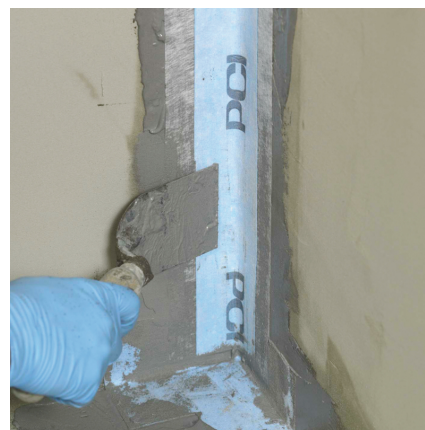
6) Hrany a rohy se utěsní izolační páskou PCI Pecitape® 120 nebo PCI Pecitape® Objekt.
