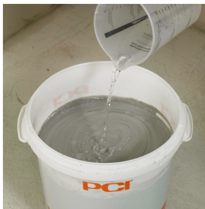
5) Pro aplikaci natíráním (1b) se přidá určité množství vody.
