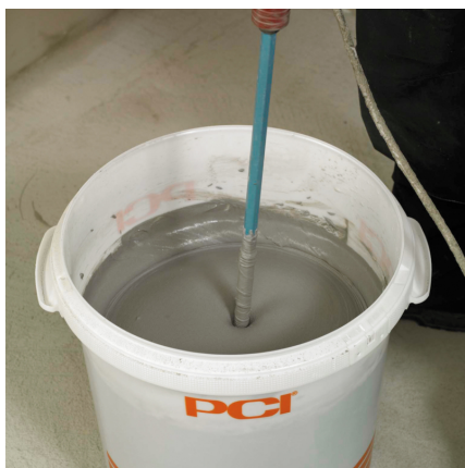
4) Pro aplikaci hladítkem (1a) rozmíchejte do homogenní směsi.
