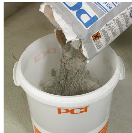
3) Následně se přidá prášková složka PCI Seccoral® 2K Rapid.
