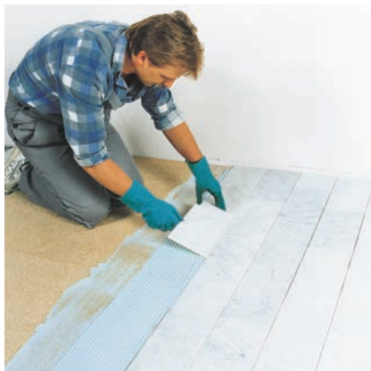
Speciální lepidlo na obklady PCI Collastic® je rovněž vhodné k položení mramoru na dřevotřískku, nebo OSB desky.
