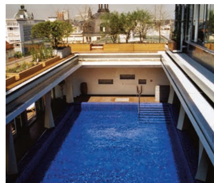
Dlažba a obklady položené v bazénu s PCI Collastic ® .
