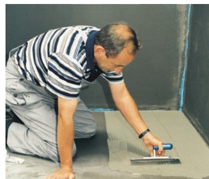
Lepidlo s přísadou PCI Lastoflex ® odbourává pnutí v podkladu a vyrovnává kolísání teplot.
