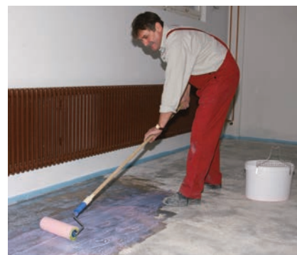
PCI Gisogrund® Rapid se nanáší neředěný rovnoměrně pěnovým válečkem na minerální podklad. Po vytvoření filmu lze okamžitě aplikovat další vrstvy.
