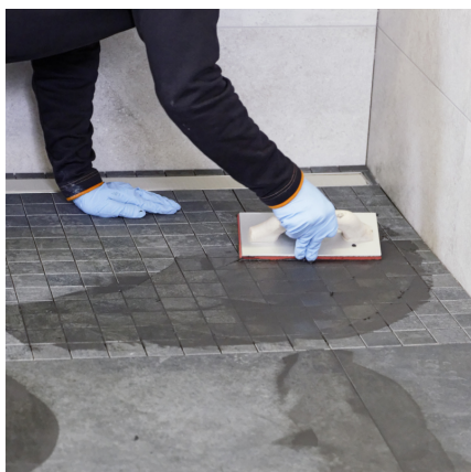
PCI Durapox Premium (Multicolor) za pomoci hladítka pro epoxidové spárovací hmoty zapracujete do plochy.
