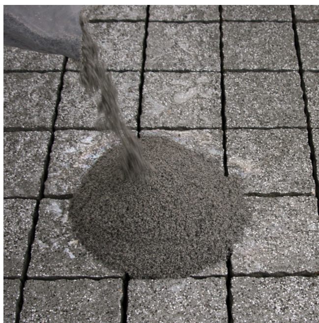
Vakuově uzavřený hliník. sáček se rozřízne a materiál vysype na plochu.
