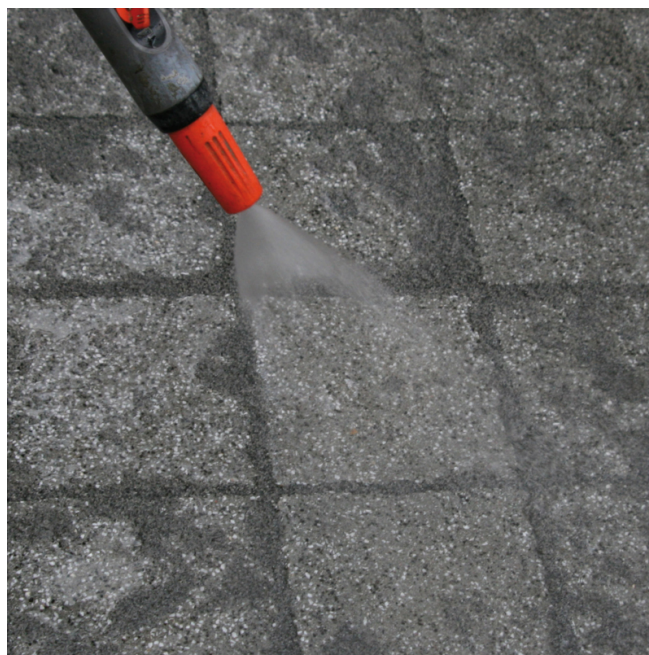
U spár od 3 do 8 mm se aplikace materiálu do spár podpoří proudem vody. Obzvlášť u úzkých spár je nutné držet proud vody delší dobu. Poté se spáry ihned doplní čerstvým materiálem.
