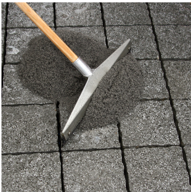
PCI Pavifix® 1K Extra se vtlačí do spár tvrdou gumovou stěrkou.
