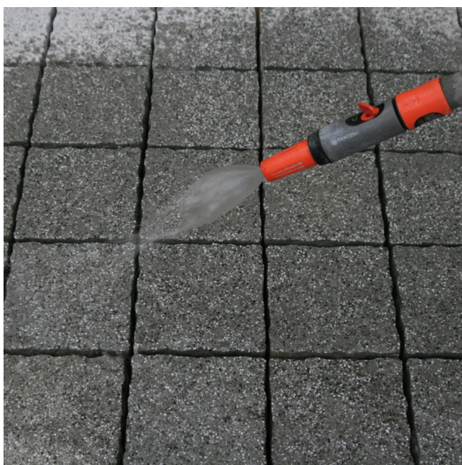
Povrch dlažby se před spárováním řádně navlhčí.
