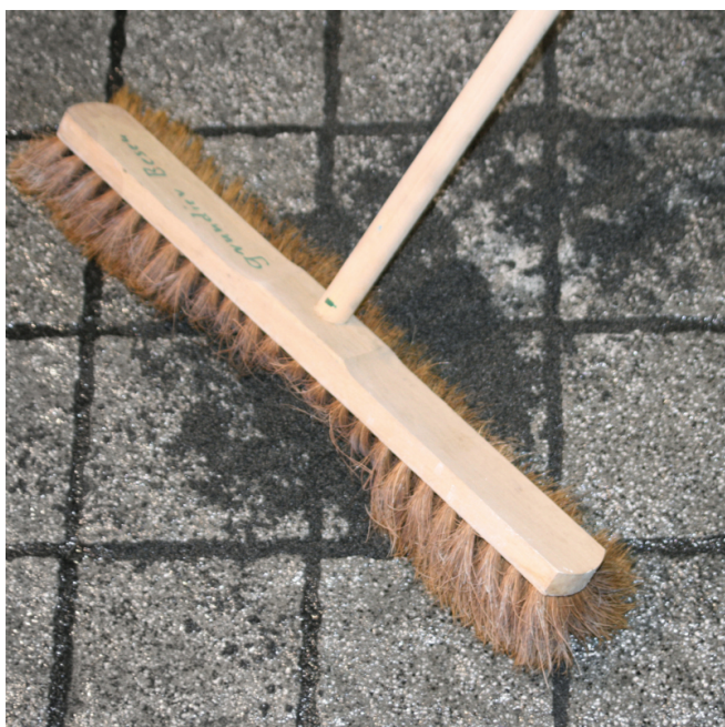
Zbytky malty se z povrchu odstraní koštětem.
